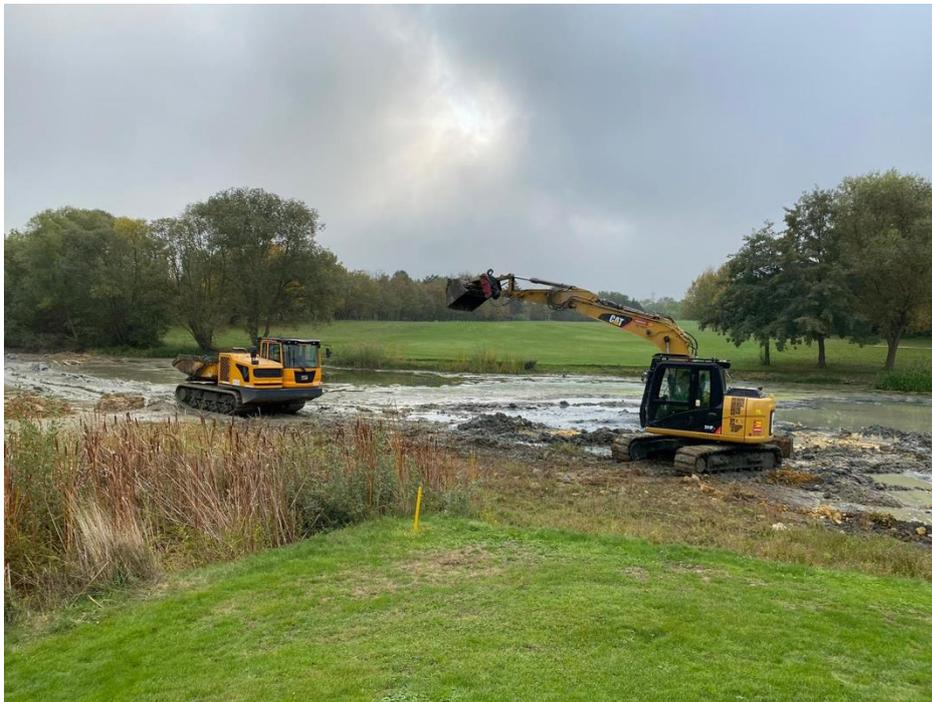
Mit großem Gerät wurde der Teich daraufhin im Oktober 2020 in einem weiten Bereich vertieft. Auf diese Weise wurden mehrere hundert Kubikmeter Teichschlamm entfernt.
